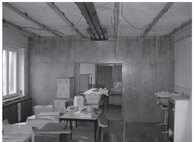
Zustand der Räume bei Übernahme durch den Verein im August 2010
