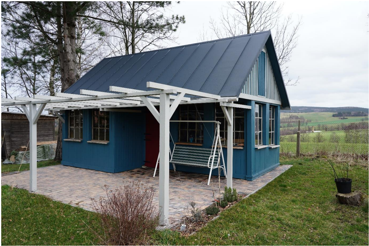
Abbildung 7: Leerstehender Bungalow auf dem Gelände
